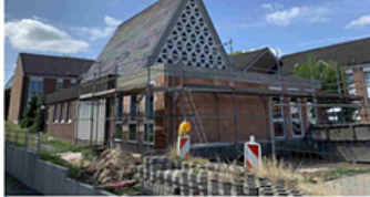
Kirchenbau am Nußberg macht Fortschritte
