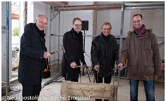
Richtfest in Troisdorf Sa, 10.02.2023
