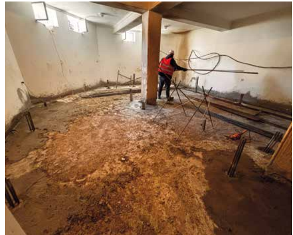
Arbeiten im Kellerbereich der Kirche in Tiflis
