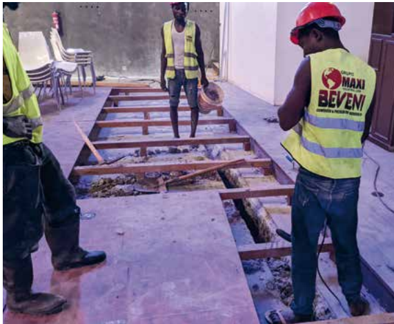
Arbeiten in der Zentralkirche Palanca (Angola)
