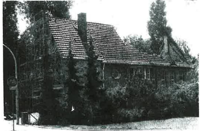
EIN ANBAU sollte die neuapostolische Kirche vergrößern. Die Arbeiten wären Ende August abgeschlossen worden. Jetzt ist der größte Teil des Dachstuhls der Kirche ausgebrannt.
