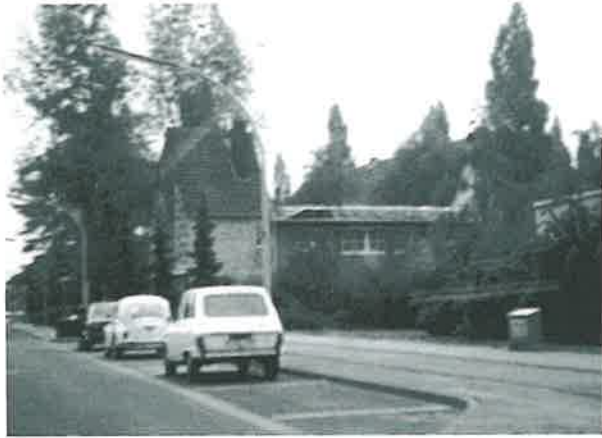
Die während der Umbauarbeiten im Jahre 1976 ausgebrannte Kirche.
