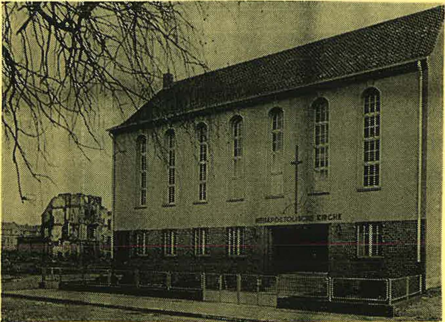
Die neuerbaute Kirche Gemeinde Kalk, Steinmetzstraße
