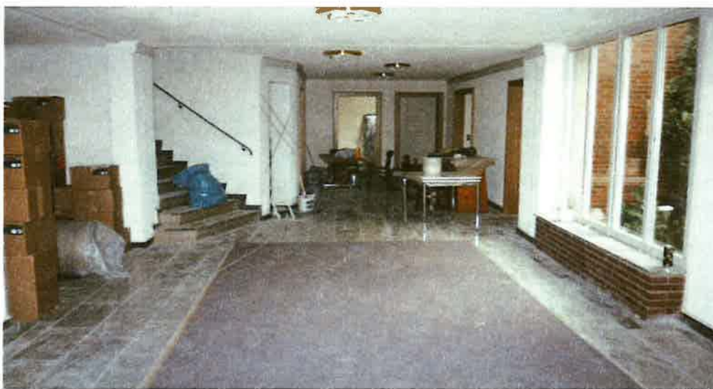
Köln-Mülheim während der Renovierungsarbeiten
