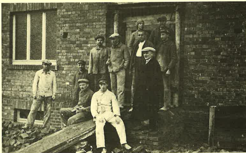
Mancher der Brüder fand bei dem Umbau im Jahre 1931 Arbeit. Vorne (sitzend): Priester Alfons Steiner, Praunheim.
