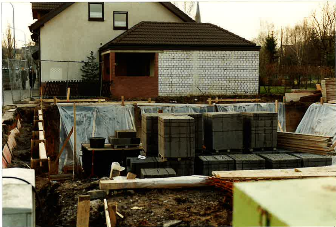
Bild 6: Die Grundsteinlegung für die neue Kirche in Brauweiler ist erfolgt
