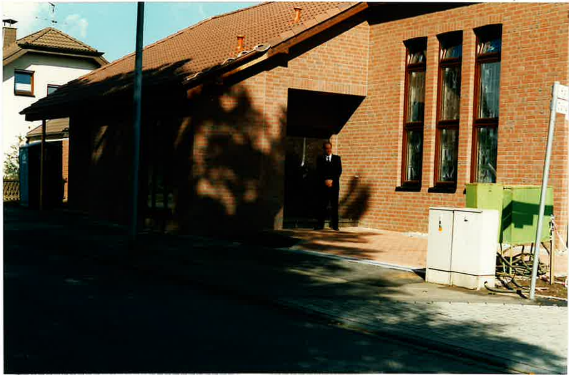
Bild 7: Die neue Kirche der Gemeinde Brauweiler unmittelbar vor der Einweihung
