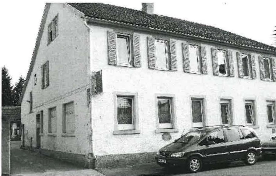
Das Gebäude in der Klein-Gerauer Straße 1 heute. In der ehemaligen Käserei fanden von 1955 – 1967 die Gottesdienste statt. Gegenwärtig ist es im Besitz des islamischen Kulturvereins.
