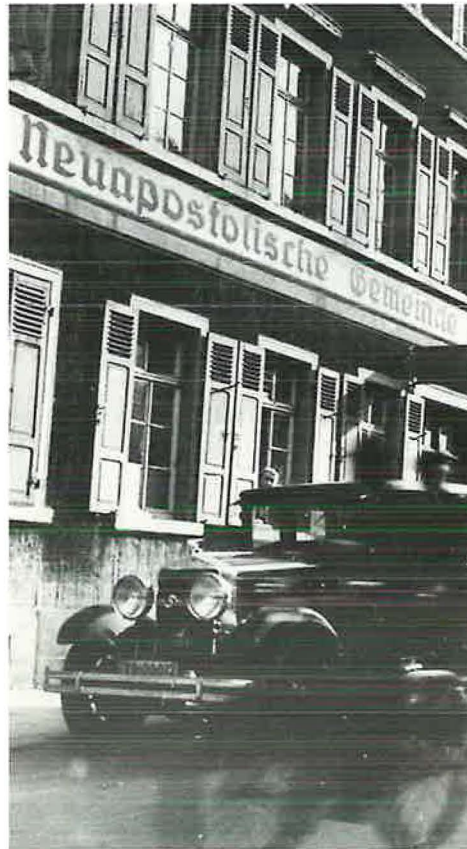
1920: Außenansicht des Gottesdienstlokales in der Gräfenaustraße 8. Es war die sechste Versammlungsstätte seit Gründung der Gemeinde Ludwigshafen
