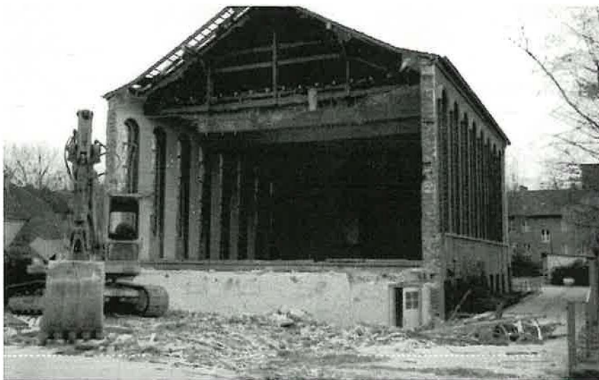
Die Kirche an der Eichenstraße während des Umbaus
