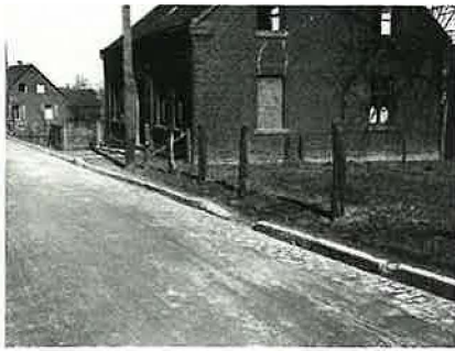
Typisches Bergmannshaus, das durch Bergschäden abbruchreif geworden ist.
