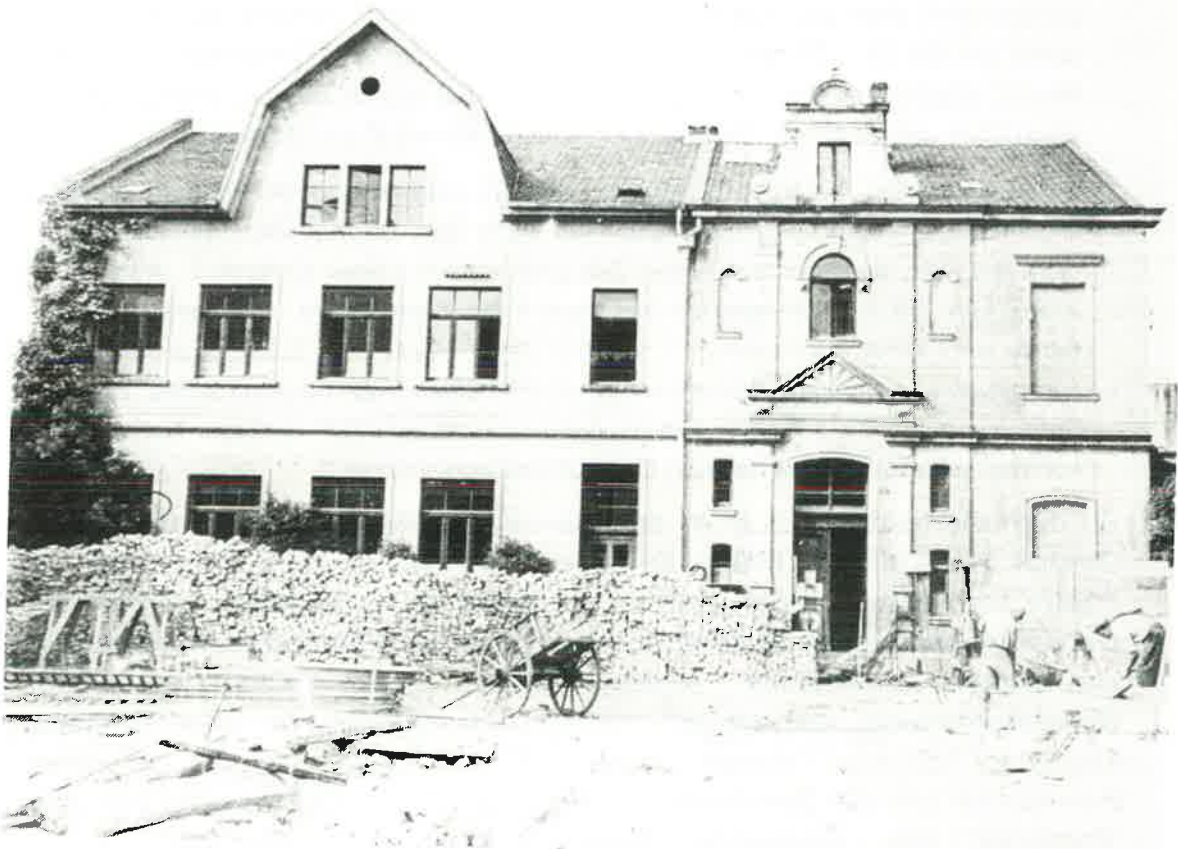
Aufnahme vom Juli 1937 des 1889 erbauten alten Rathauses, Koblenzer Straße 40, (rechter Gebäudeteil) mit dem 1914 errichteten Erweiterungsbau (linker Gebäudeteil).
