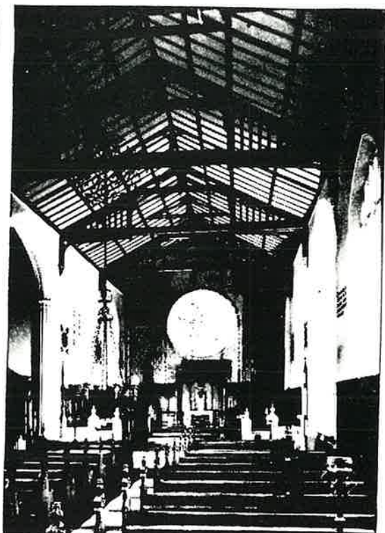
Westfront und Innenansicht der 1840 durch Henry Drummond in Albury erbauten "Apostelkirche".
