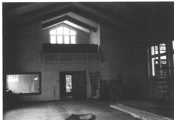
Während der Umbauarbeiten
