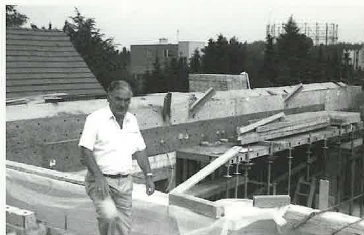
Bezirksapostel Engelauf besichtigt die Baustelle
