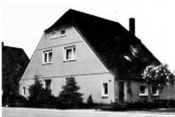
Das Haus Nr. 11 in der Beverstraße (früher Walsstraße)
