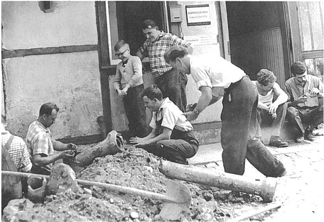
Renovierungsarbeiten in Selbsthilfe
