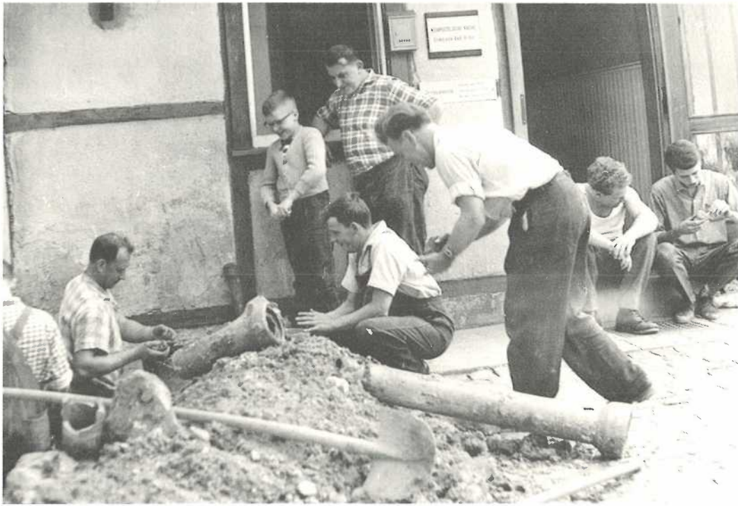
Renovierungsarbeiten in Selbsthilfe
