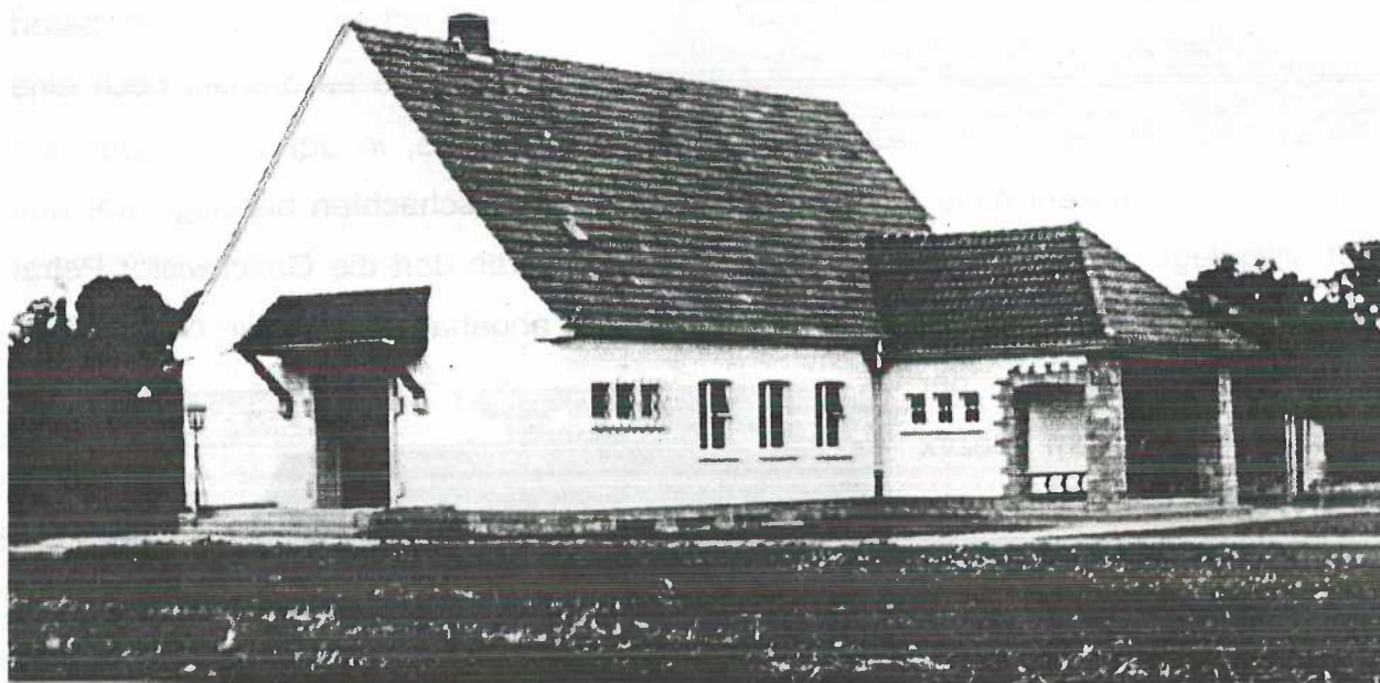
Abb. 6 Die neue Kirche an der Eschstrasse 1952
