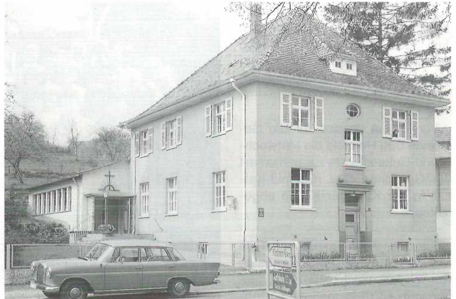
Kirchengebäude vor dem Umbau (links ist der im Jahr 1964 errichtete Anbau zur Erweiterung des Kirchensaals zu sehen)
