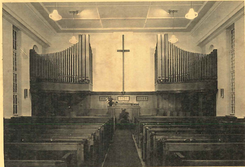
Innenansicht der Kirche in der Birresborner Straße (1955)
