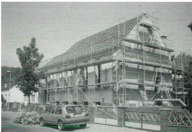
Neuapostolische Kirche - Umbaubeginn Juli 1995 (1)
