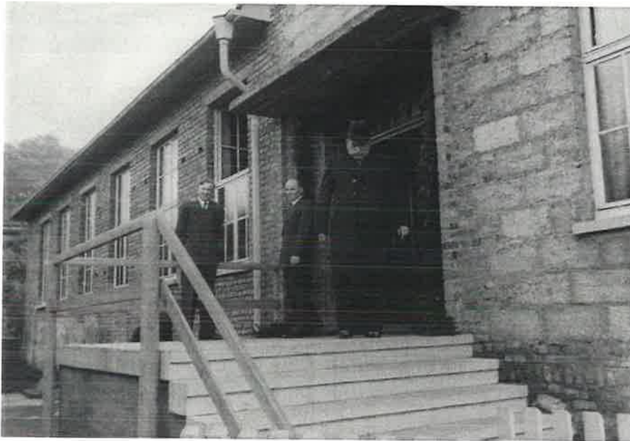
Der Stammapostel besichtigt den Wie- deraufbau.
