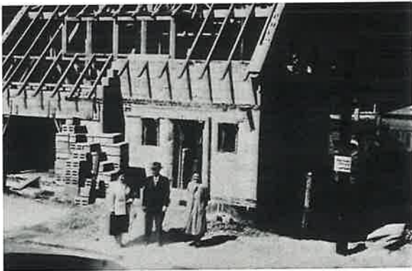
Neubau in Eiserfeld, Grabettstraße 81
