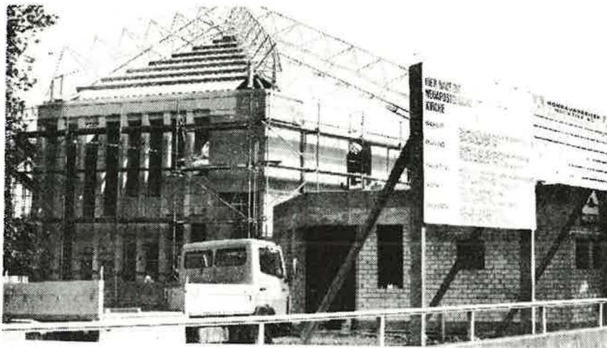
Gestern war Richtfest am Neubau der Neuapostolischen Kirche an der Koblenzer Straße. (WR-Bild: Horstgünter Siemon)
