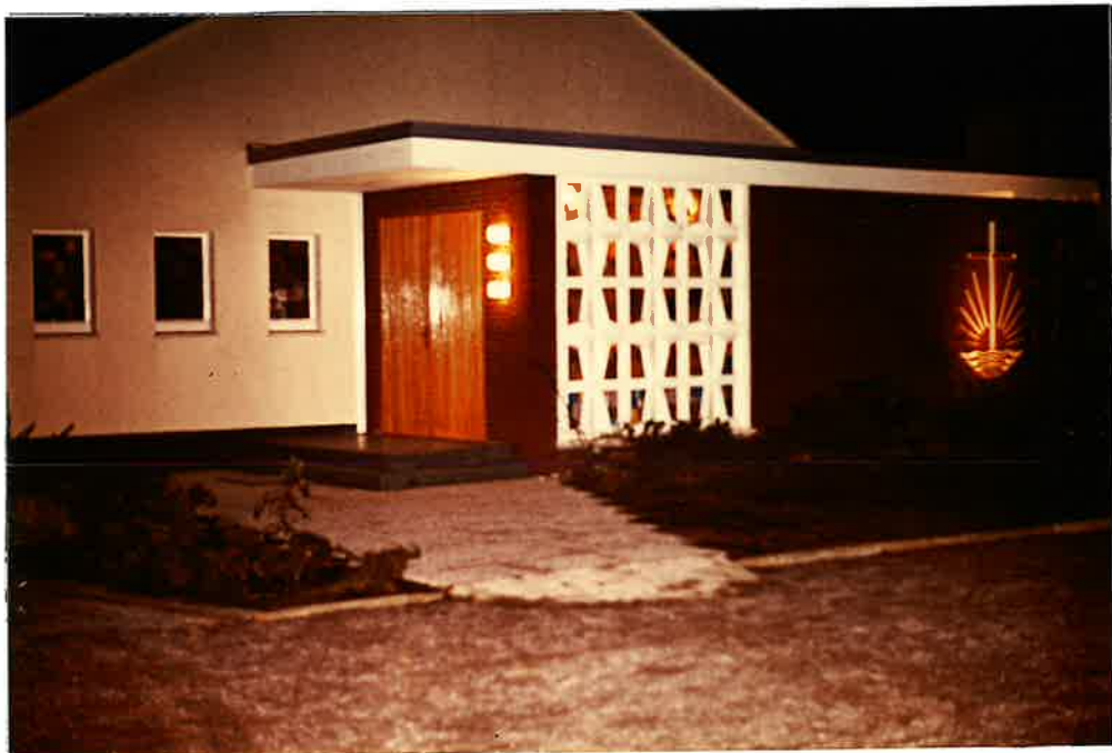
Kirche nach dem Umbau
