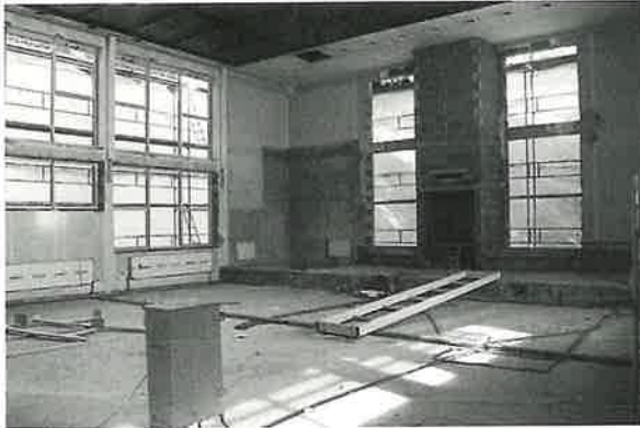
Kirchenschiff während der Renovierungsphase
