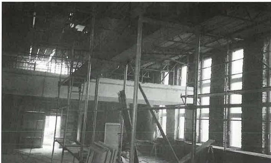
Die Gerüstkonstruktion im Kirchenschiff
