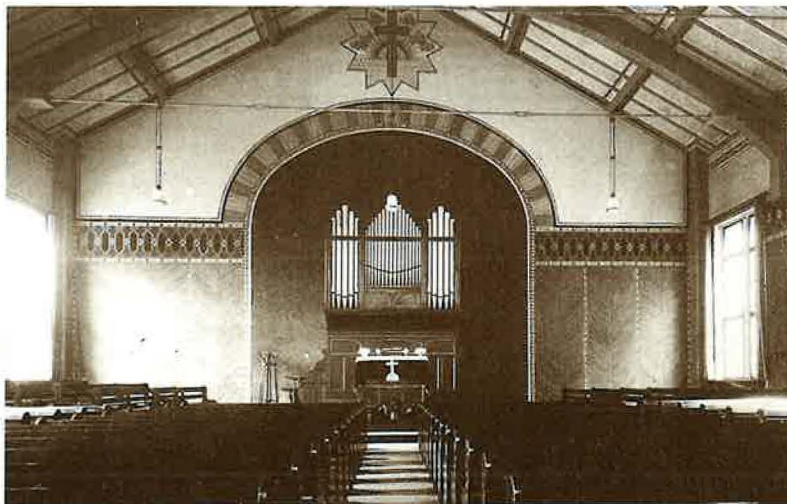
Kirche in Frankfurt am Main-Südwest in der Hufnagelstraße. Sie wurde 1924 erbaut.
