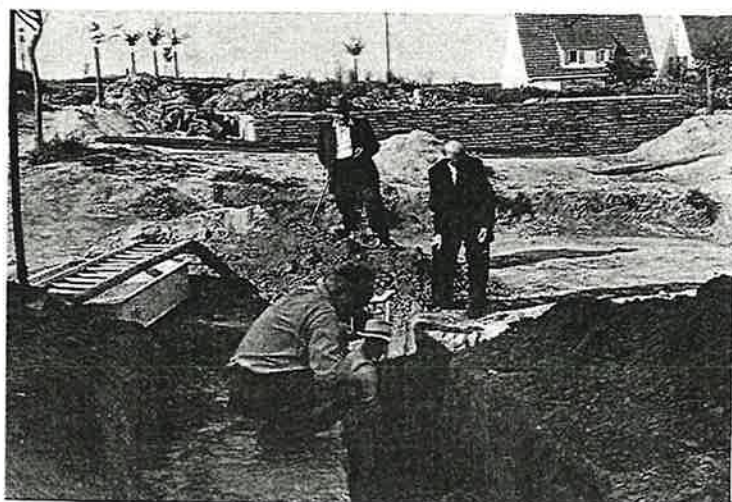
Ausschachtungsarbeiten: Bruder Stephan und Gemeinde-Ältester Becht sind eifrig an der Arbeit
