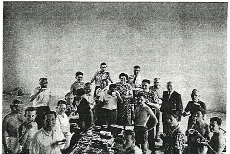
Innenausbau der Kirche
