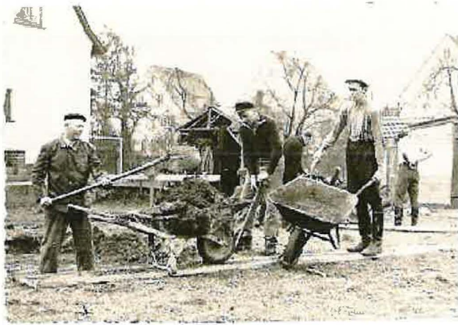
Fleißige Mithilfe beim Bau der neuen Kirche
