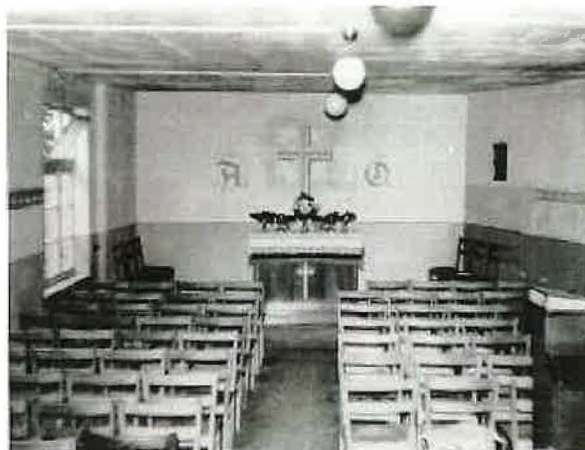
Innenansicht des alten Gemeindelokals in der Frankfurter Straße
