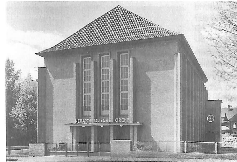
Die schöne, neuerbaute Kirche an der Wanner Straße
