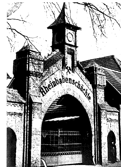
Das alte Zechentor der Schachtanlage Rheinbaben.
