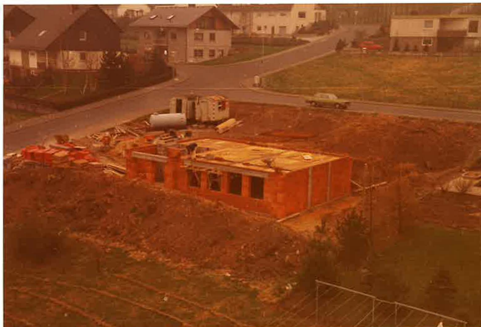
Am 02.04.1981 war das Kellergeschoß fertig
