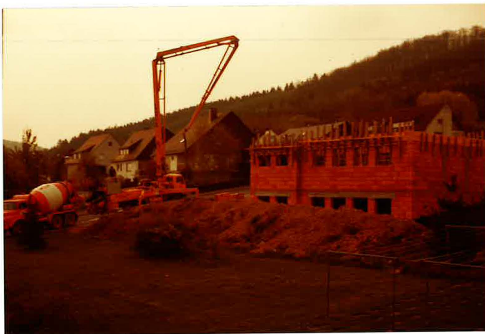
Ende April wurde der Fertigbeton geliefert
