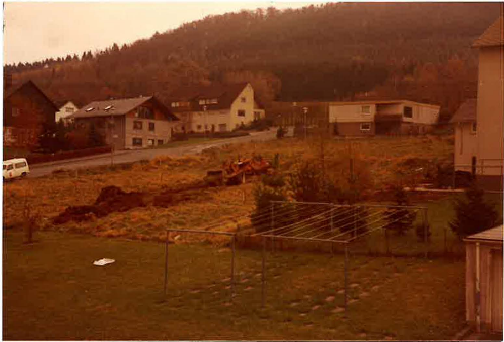
Beginn der Erdarbeiten
