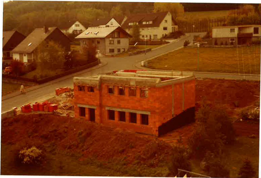
Baustand Mitte Mai 1981
