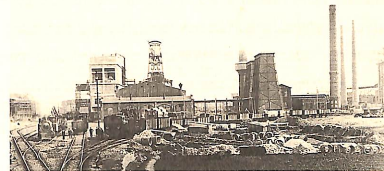
Die Tagesanlagen Maximilian 1 / 2 kurz vor der Fertigstellung 1910
