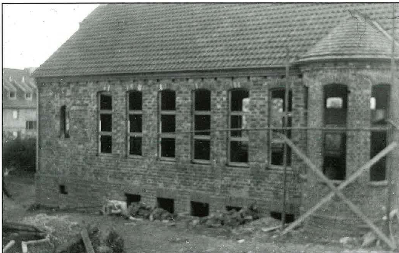
Die Bauarbeiten an der Kirche in der Königstraße machen Fortschritte.
