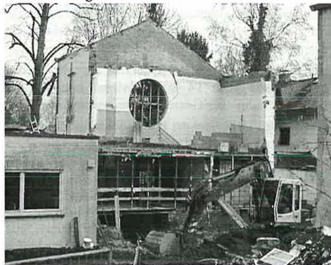
Das Kirchenschiff ist abgerissen, die Fassade wird teilweise erhalten
