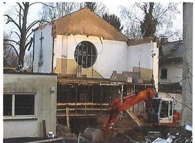
Das Kirchenschiff ist eingerissen, Teile der Fassade bleiben erhalten
