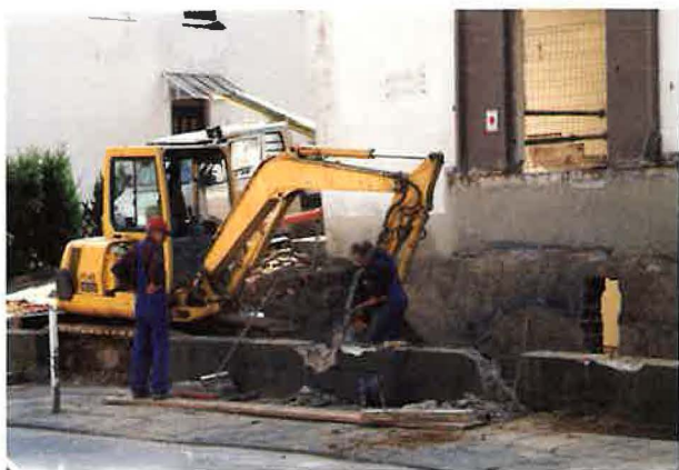
Ausschachtungsarbeiten für neuen Vorbau
