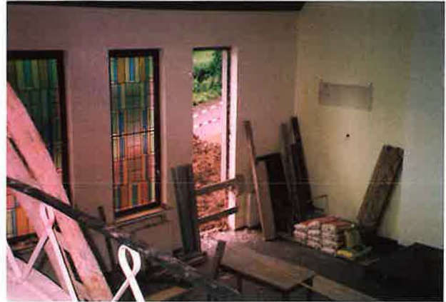
Umbau im Kirchenschiff
