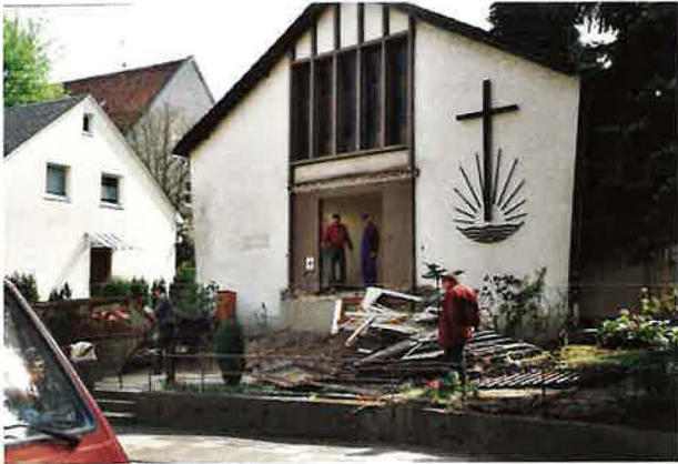
Abriss der Eingangstreppe
