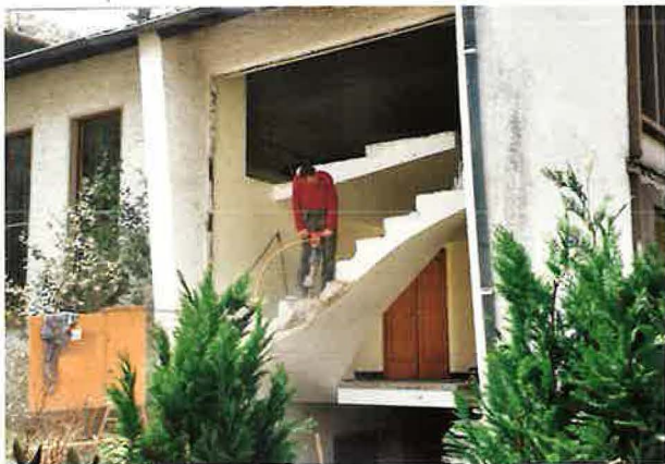
Abriss innen (Flur)
