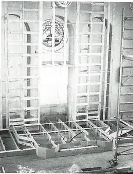
Beim Umbau; die Altarwand
