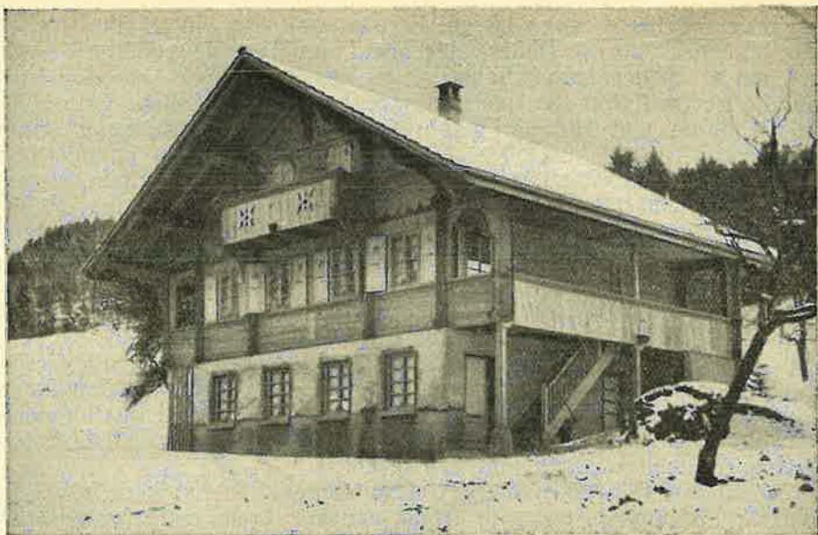
Das durch Vorsteher Ernst Moerker neu erbaute Haus. Im Parterre befindet sich das Versammlungslokal.
