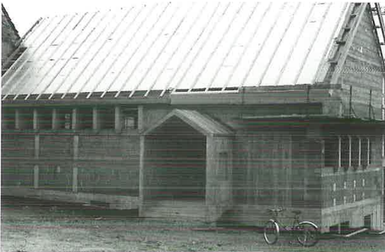
Kirche im Rohbau
