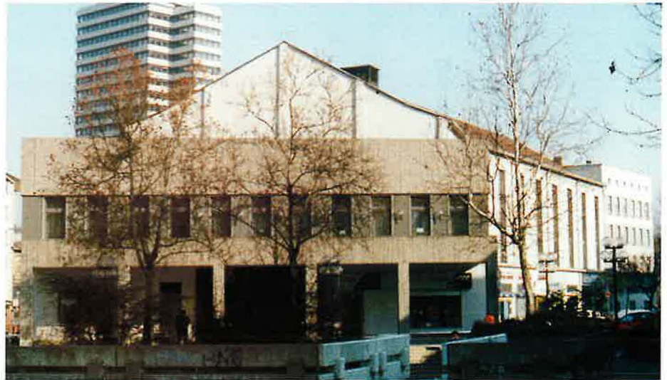
Außenansicht des Pfalztheaters
