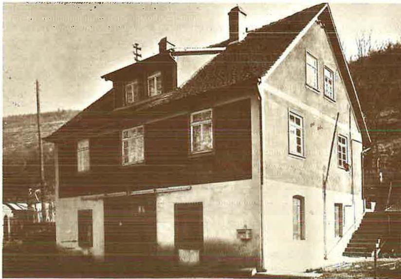
Haus in der Mühlenstraße 57, in dem unsere Gottesdienste stattfanden
