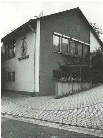
Außenansicht der Kirche Wertheim
