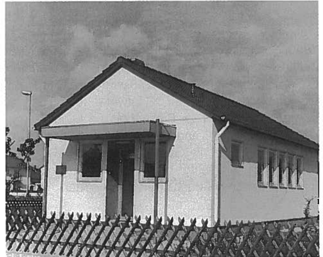
Die alte Kirche in der Posener Straße 2
