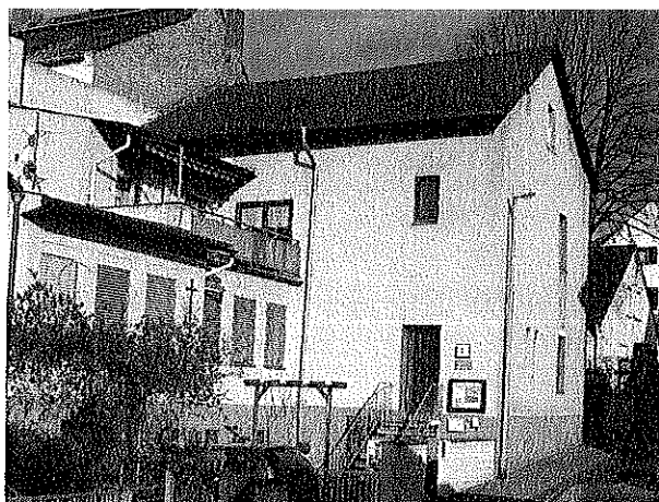
Wilhelmstraße 3, Außenansicht März 2007
