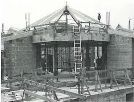
Arbeiten am Eingangsbereich
