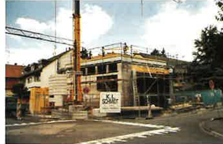
Beginn der Bauarbeiten „Im oberen Stichel“, Juni 2004
