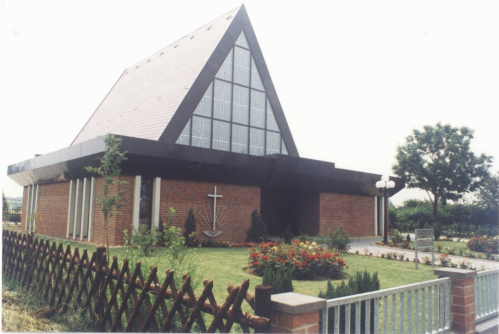
Fertigstellung der Kirche am 26.05.1991
