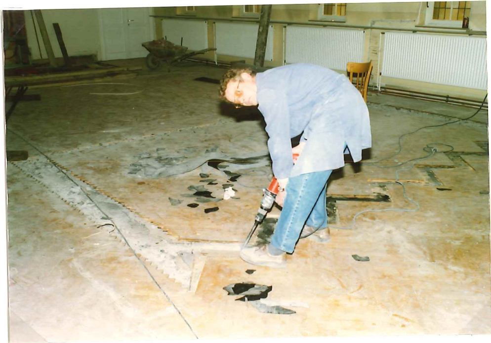
Stemmarbeiten für die Induktionsschleife
