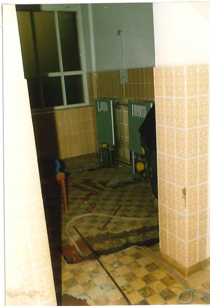
Das Damen-WC nach Freilegung der Grundleitungen
