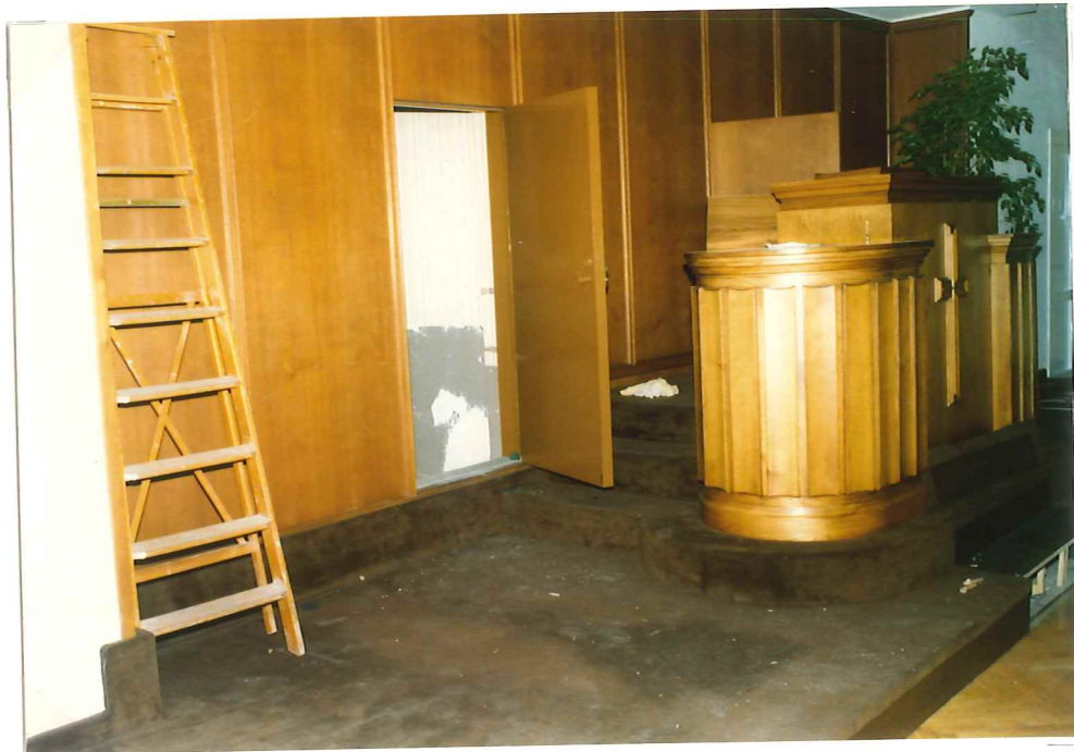
Zugang zur alten Übersetzerkabine
