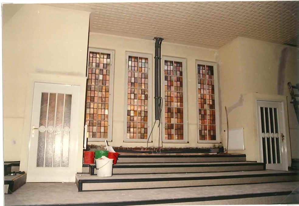
Der Platz für die zwei neuen Übersetzerkabinen, im Hintergrund die HT-Rohre für spätere TV-Übertragungen
