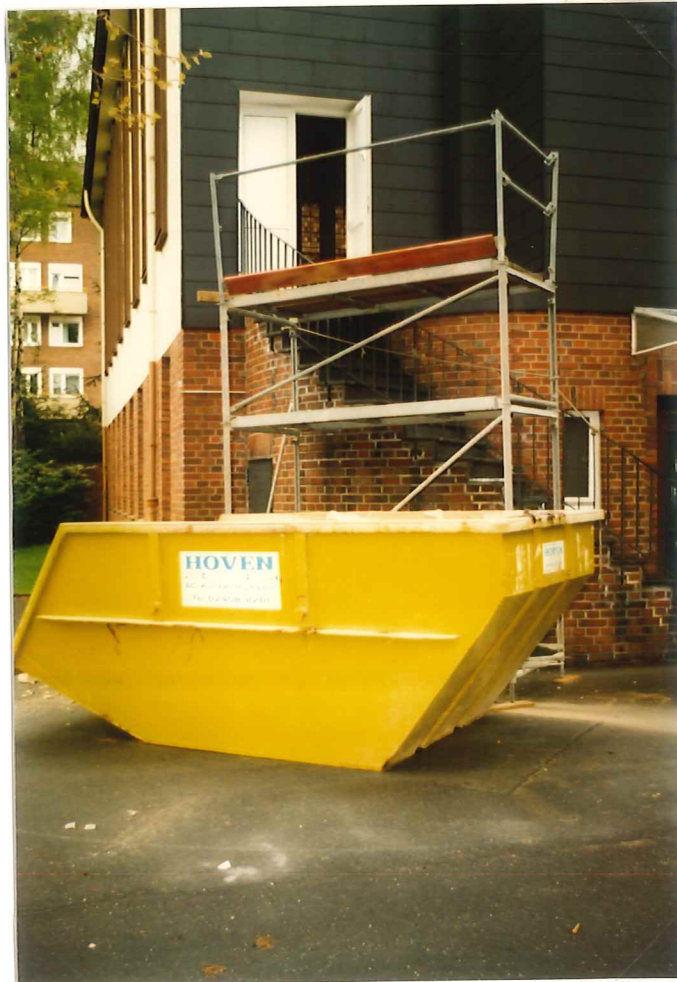
Ein weiterer Container für die Schuttbeseitigung
