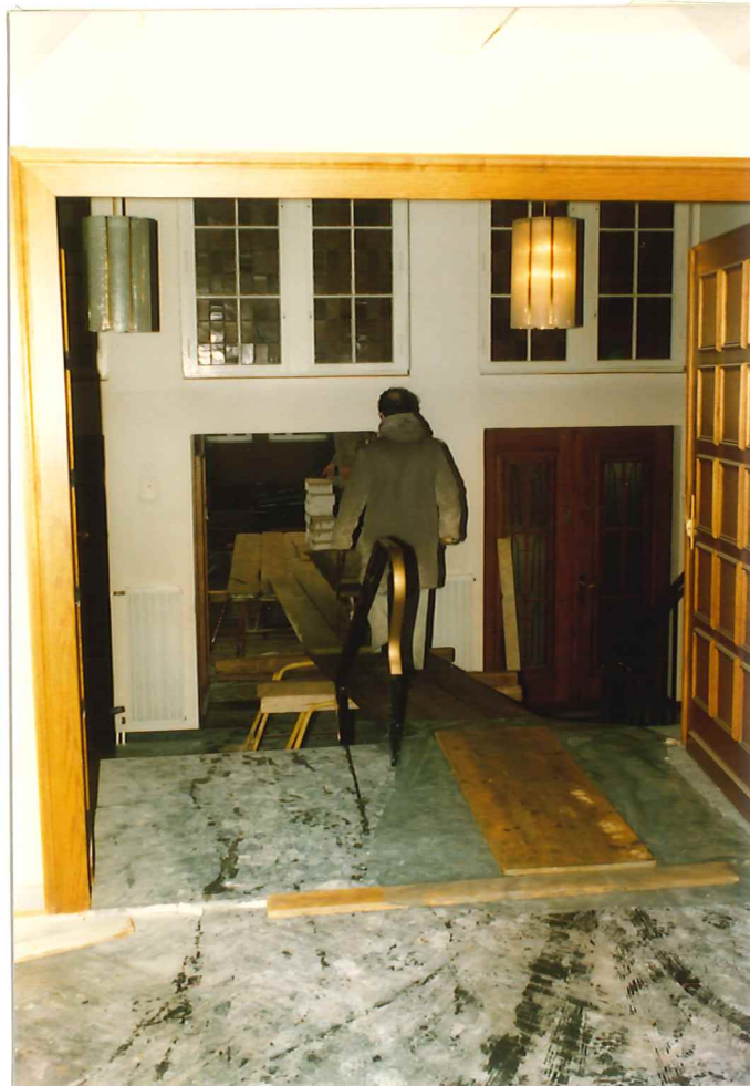
Materialbeschaffung über ein Gerüst
