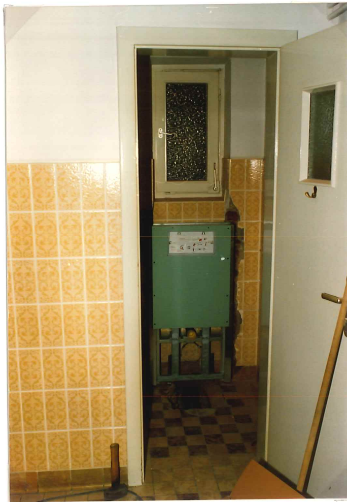
Das Herren-WC nach Installation der Santro-Wand
