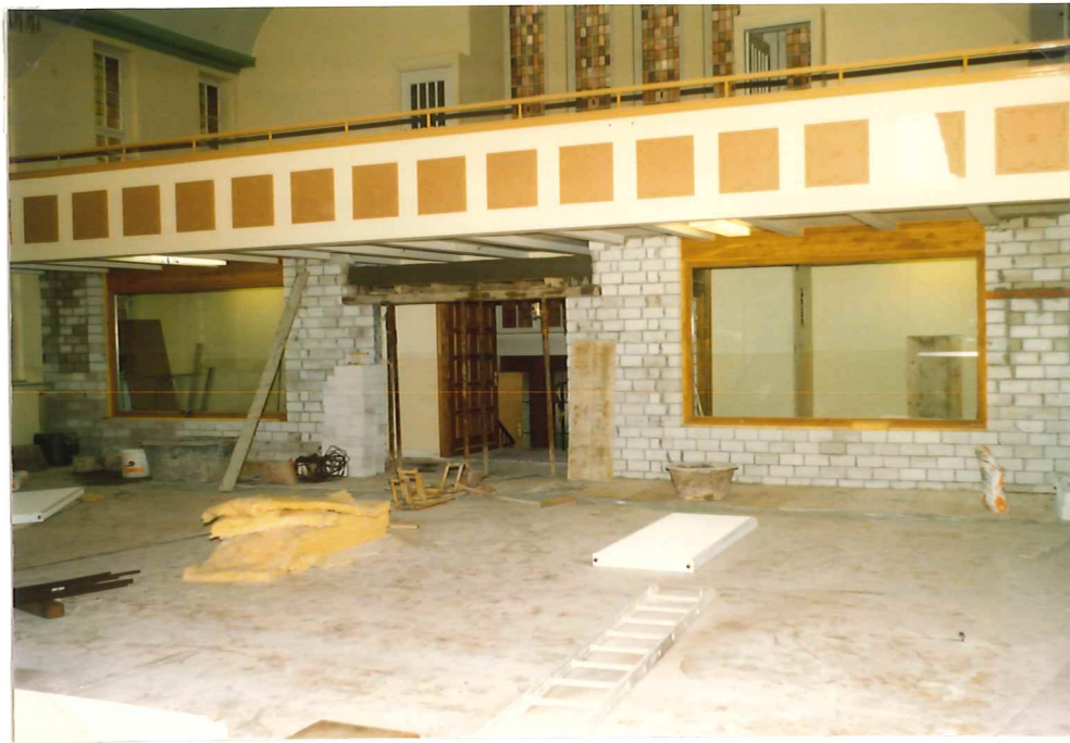
Die massive Abtrennung mit neuem Saaleingang
