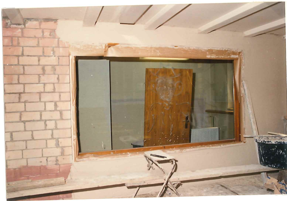
Verputzen der Mutter/Kindräume
