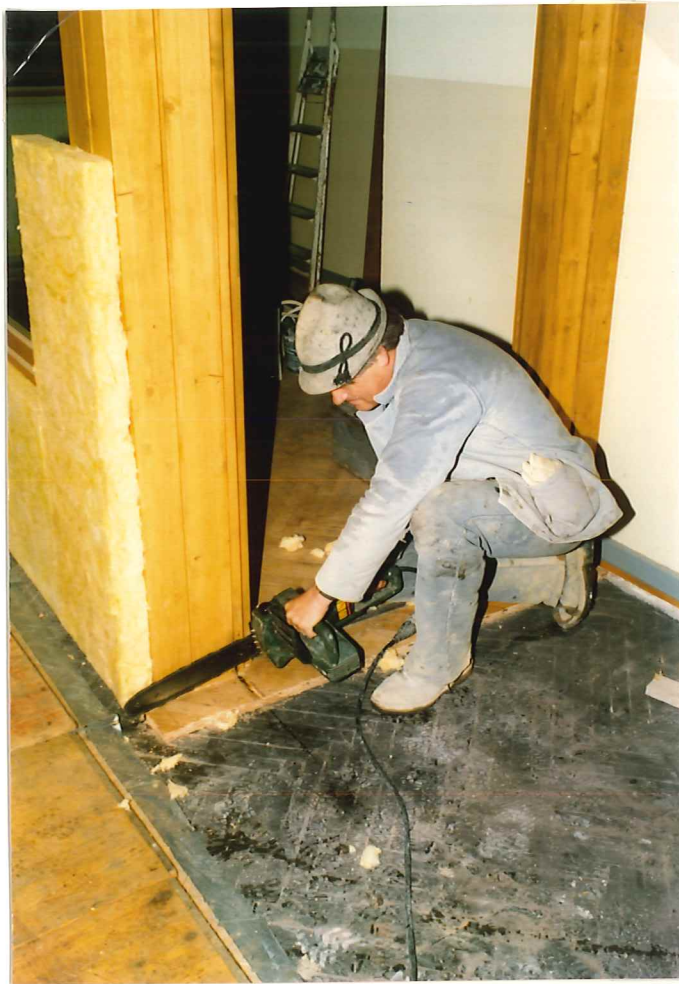
Vorbereitungen für das mauern der 11,5 cm KS-Wand vor den Mutter/Kindräumen
