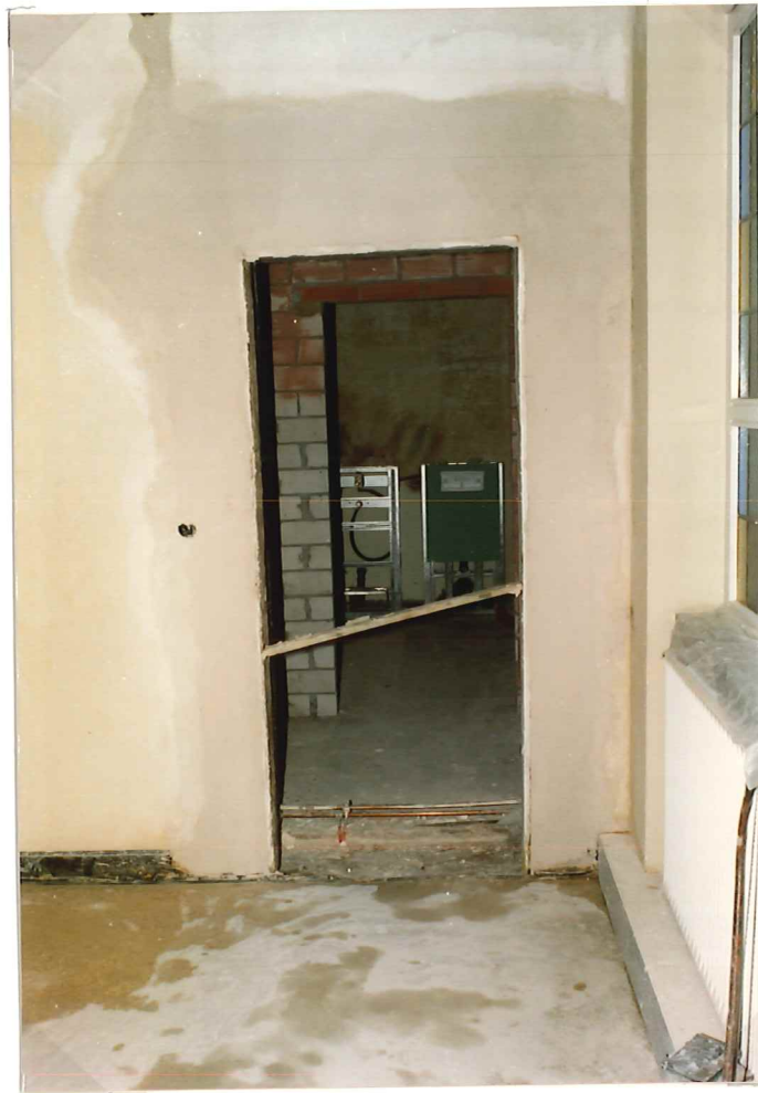
Das neue Ämter-WC im Rohbau
