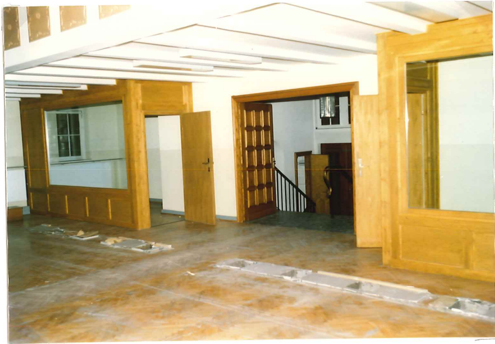
Die Mutter/Kindräume, davor die Luftaustrittsöffnungen (unter den Bänken) der alten Heizung
