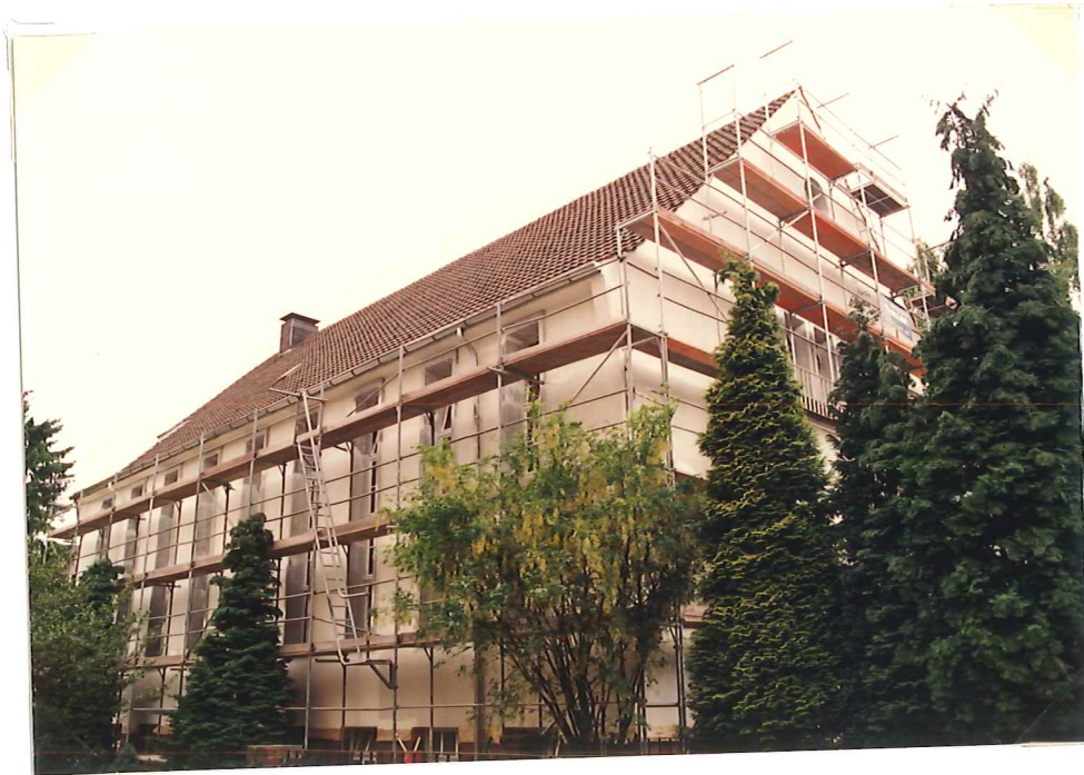
Das Gerüst für den Aussenanstrich, sowie für das Anbringen der neuen Rinnen
