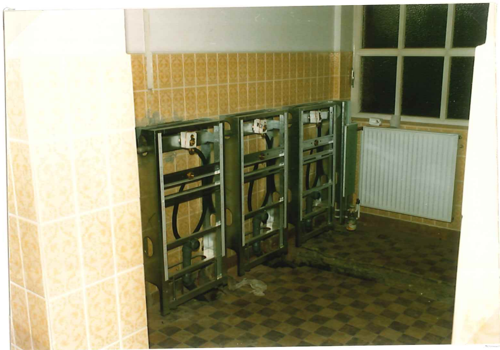
Vorbereitung der Trägerelemente für die Urinalbecken
