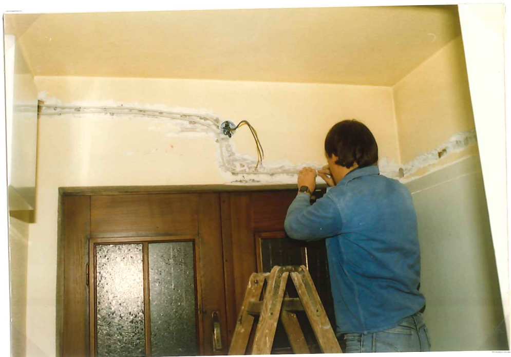
Leitungsverlegung am hinteren Eingang
