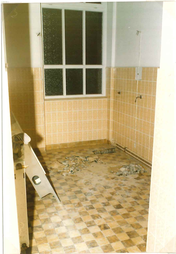
Das Damen-WC nach Entfernung der Trennwand
