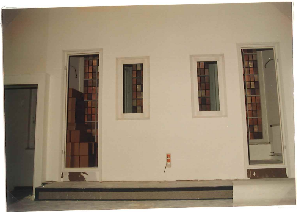
Die neuen Übersetzerkabinen, fast fertig
