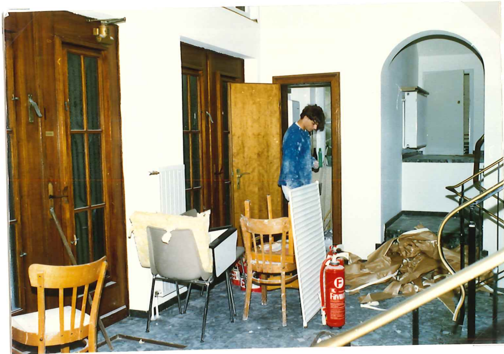
Malerarbeiten im Foyer
