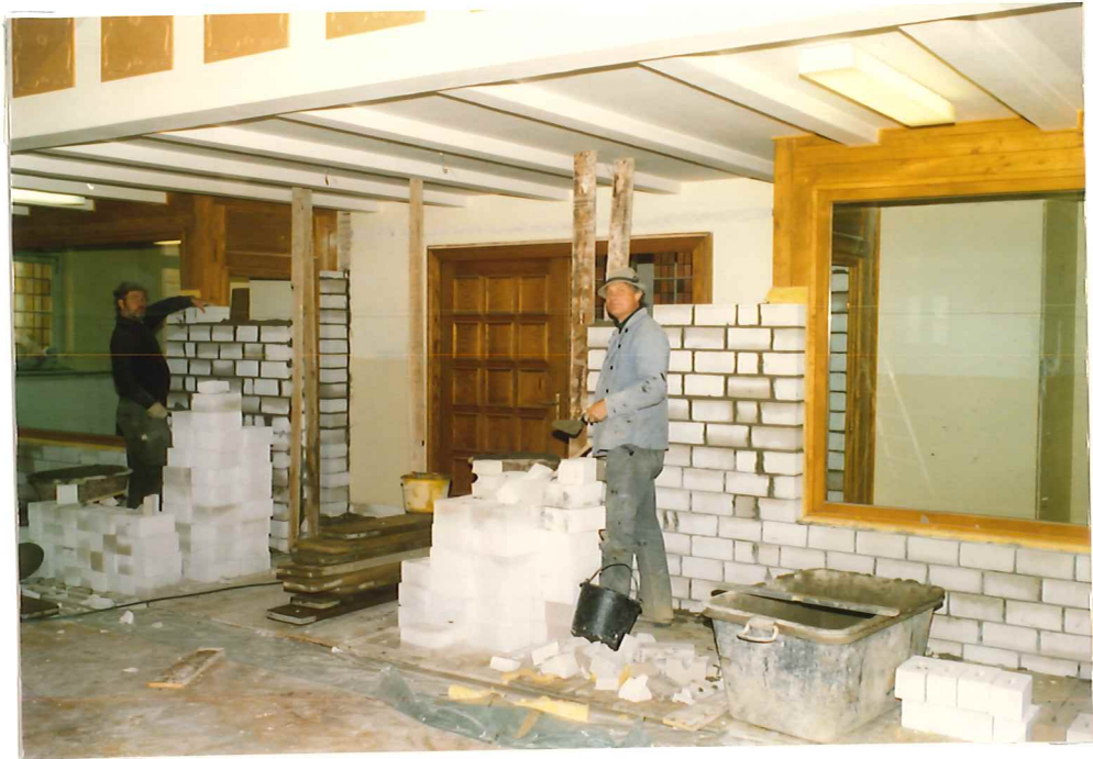
Der neue Saaleingang im Rohbau
