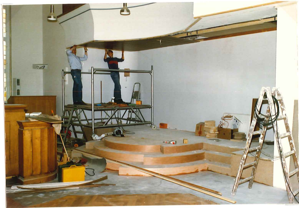
Anbringen der Deckenpaneele, mit neuer Podestanlage
