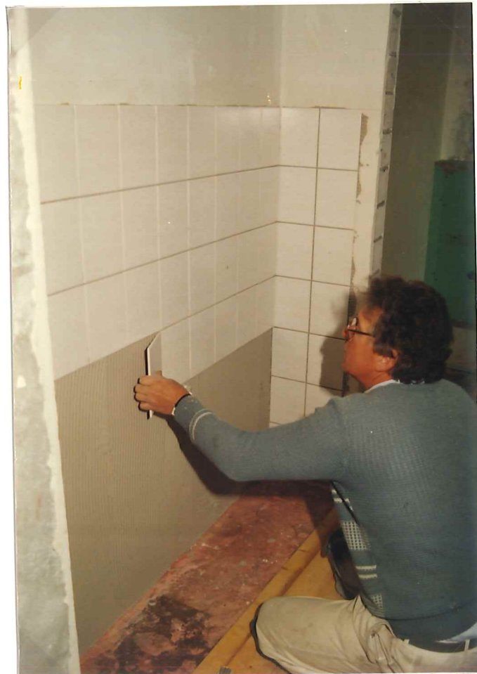
Fliesenarbeiten im neuen Ämter-WC
