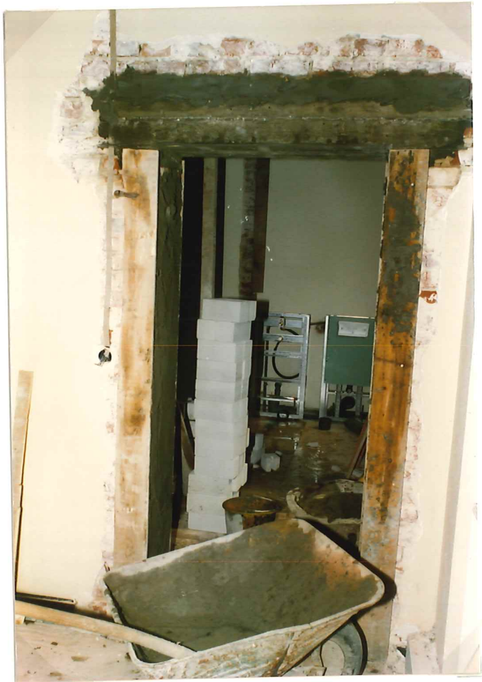
Der Türdurchbruch mit Sturz zum neuen Ämter-WC
