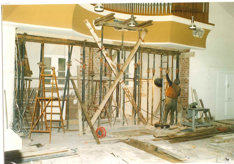
Der neue Altarbereich mit Abstützung
