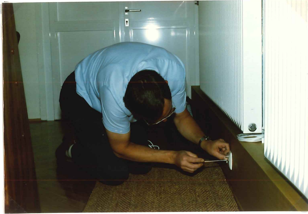
Die ELA-Beauftragten und deren Helfer bei der Endmontage
