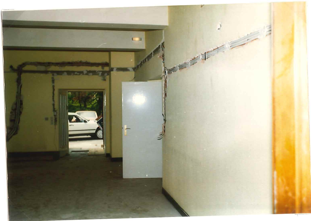
Verlegte Leitungen im Jugendraum zur neuen Übergabestelle
