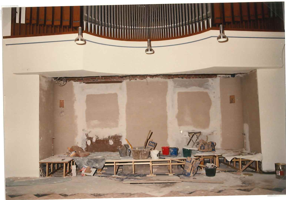
Der neue Altarbereich fertig verputzt
