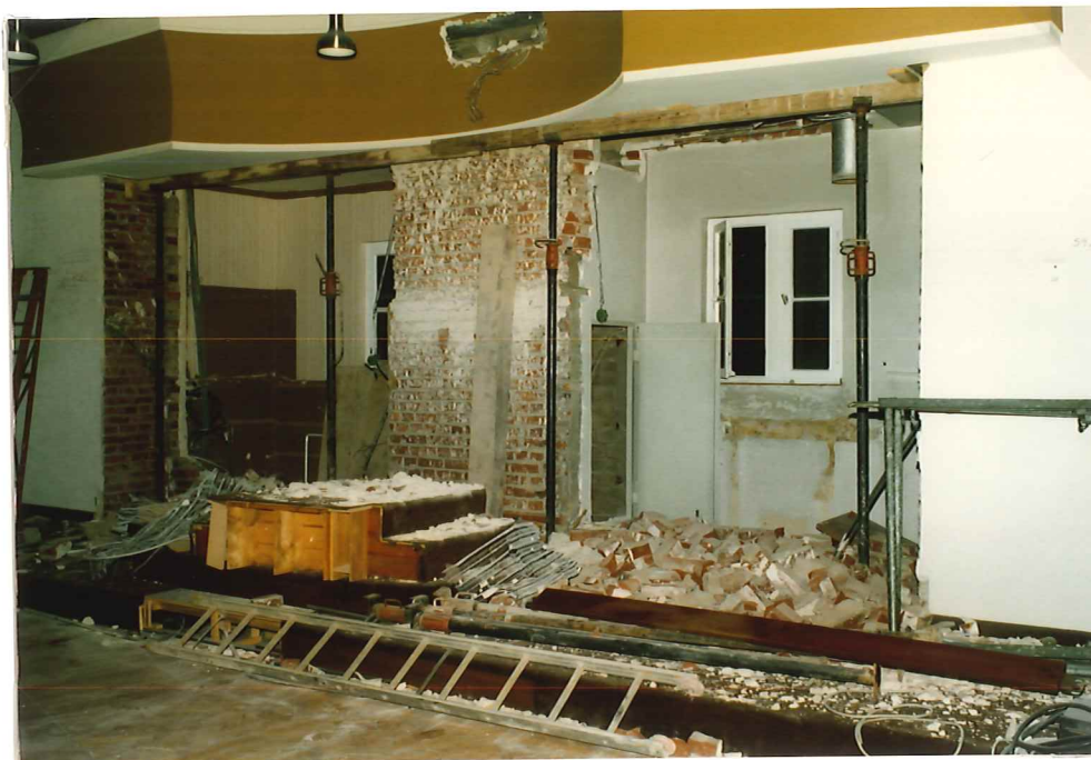
Die letzte Trennwand fehlt noch
