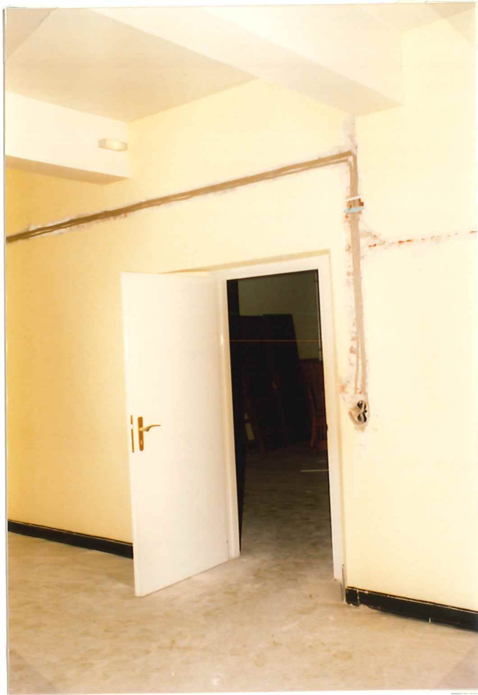
Verlegte Leitungen im Jugendraum
