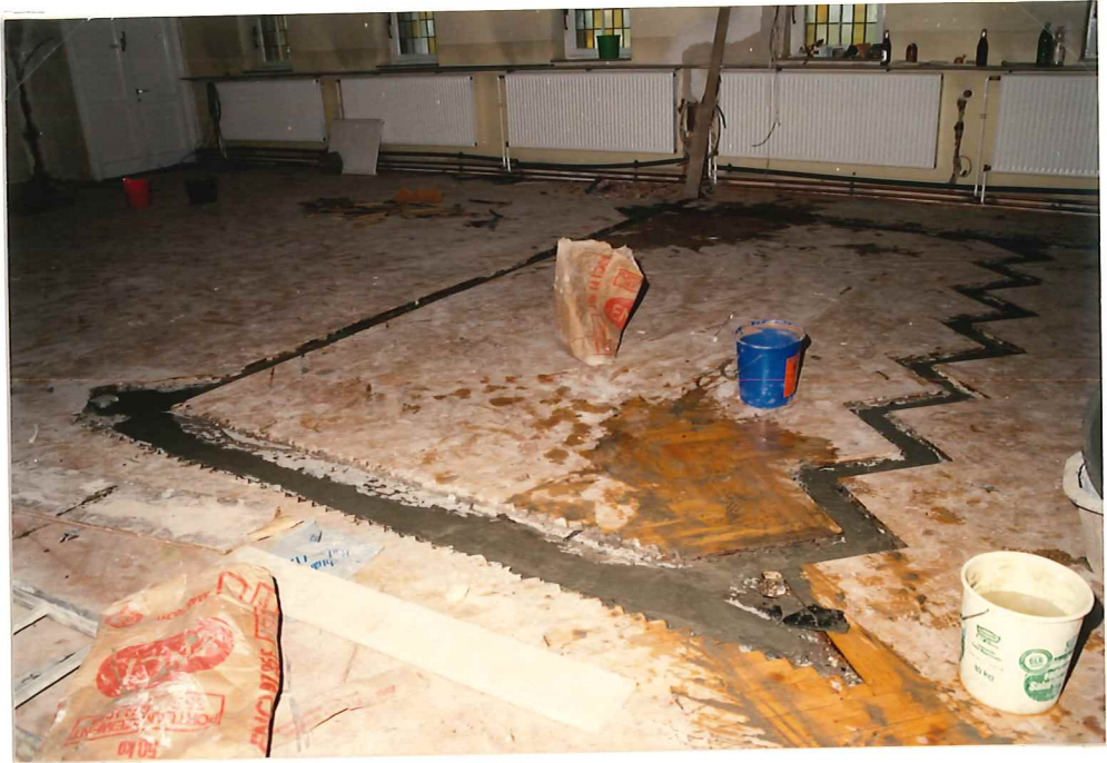
Schließung der Bodenschlitze für die Induktionsschleife
