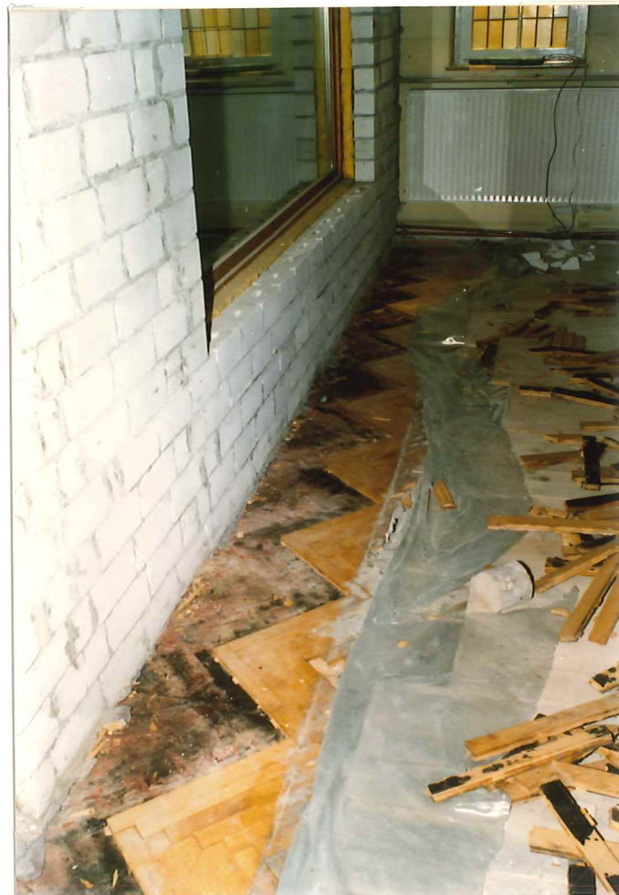
Das Parkett mußte teilweise aufgenommen werden
