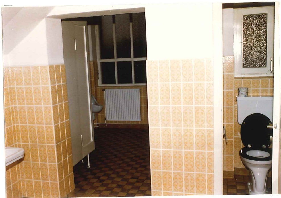
Die alte Herren-WC-Anlage
