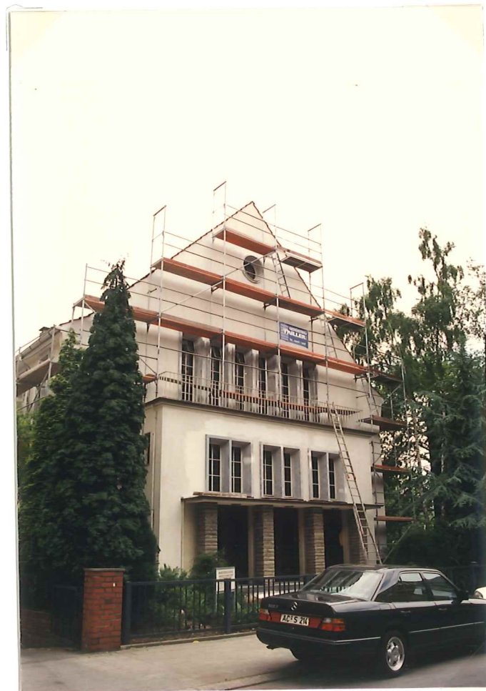
Das Gerüst für den Aussenanstrich, sowie für das Anbringen der neuen Rinnen
