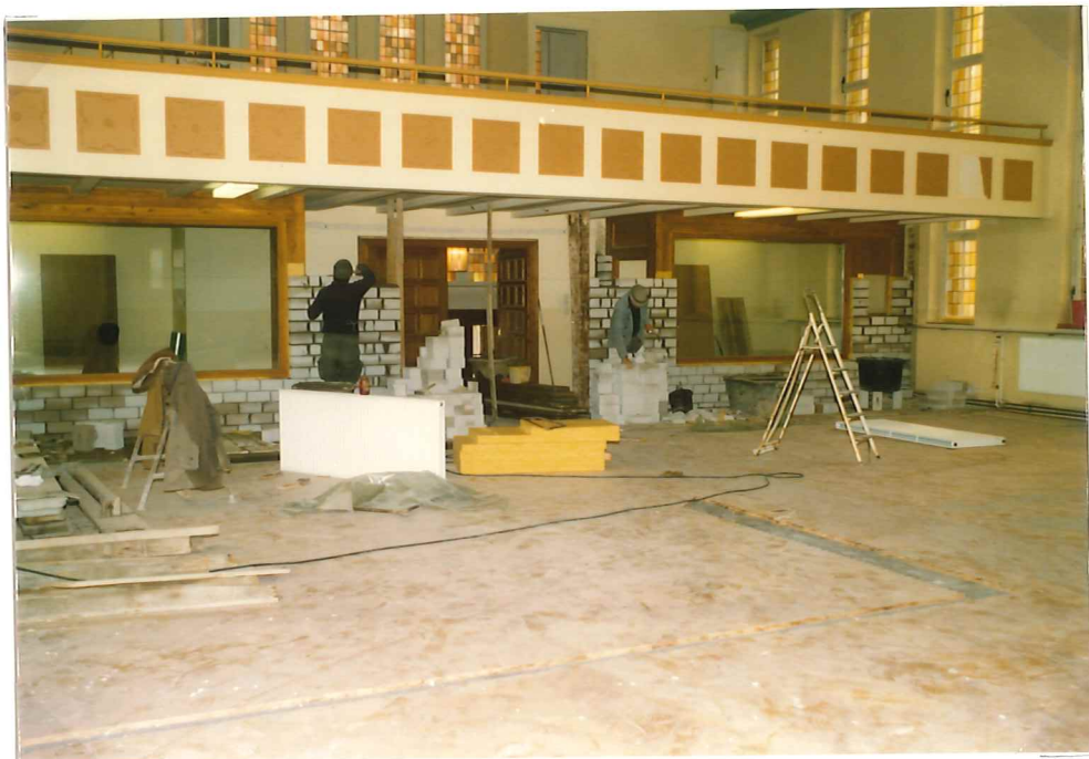
Der neue Saaleingang im Rohbau
