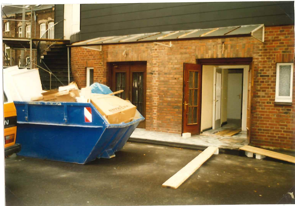
Einer von vier Containern zur Schuttbeseitigung
