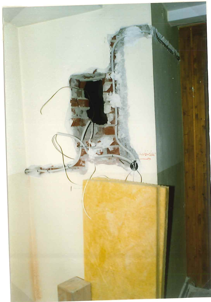
Durchbruch für Lautsprecherbox mit Leitungsführung in einem Mutter/Kindraum
