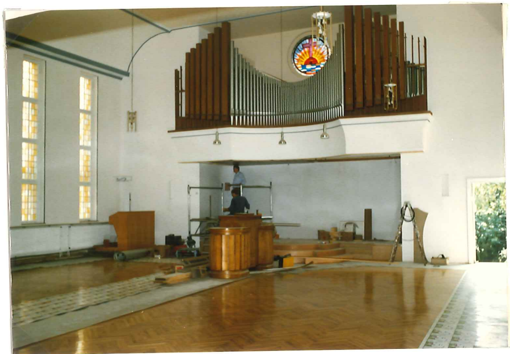
Vorbereitungen für die Paneele im Altarbereich, das Parkett ist fertig
