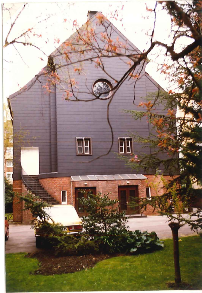
Westansicht des rückwärtigen Giebels
