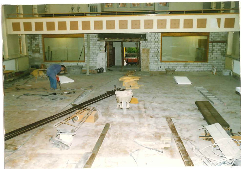
Stemmarbeiten für die Induktionsschleife
