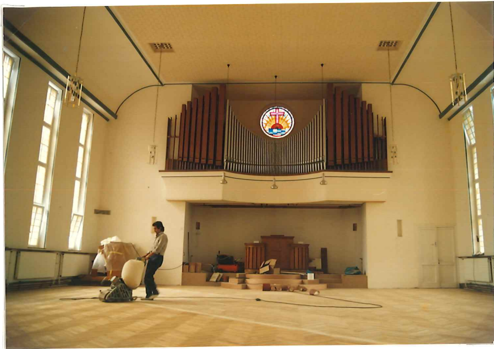
Die neue Podestanlage, das Parkett wird abgeschliffen
