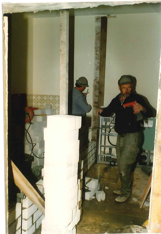
Trennung des alten Ämterzimmers in Abstellraum u. WC
