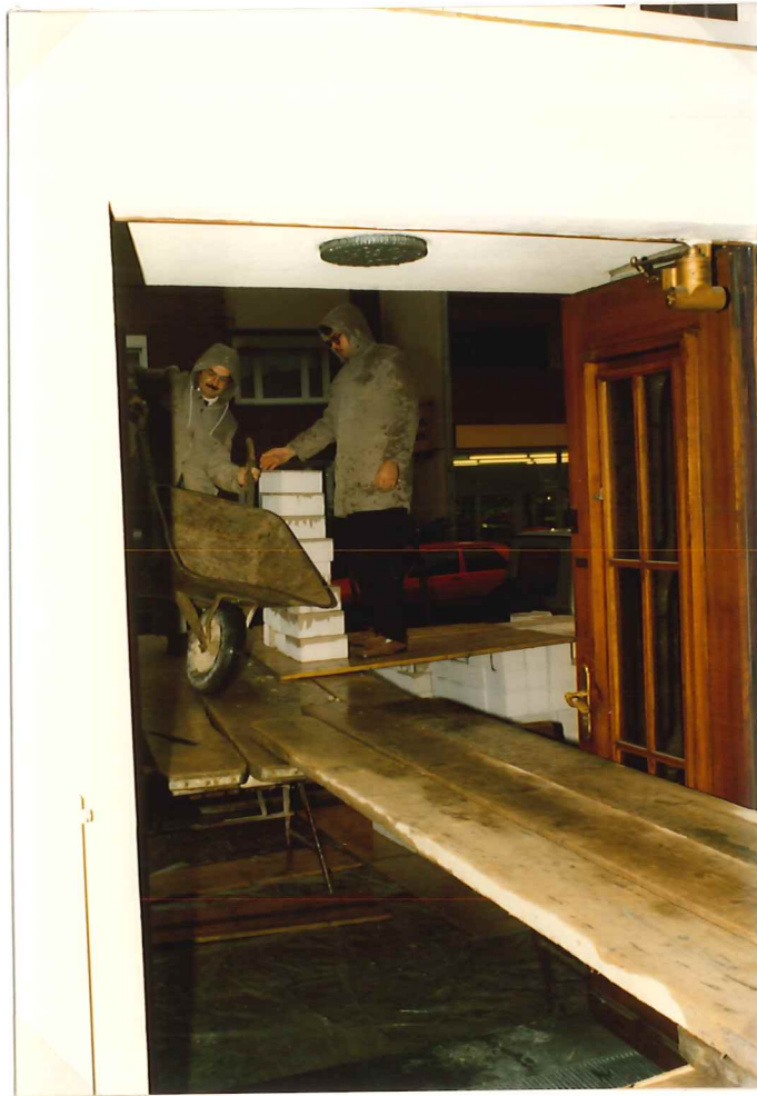
Materialbeschaffung über ein Gerüst
