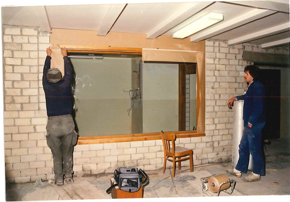
Vor dem verputzen der Mutter/Kindräume
