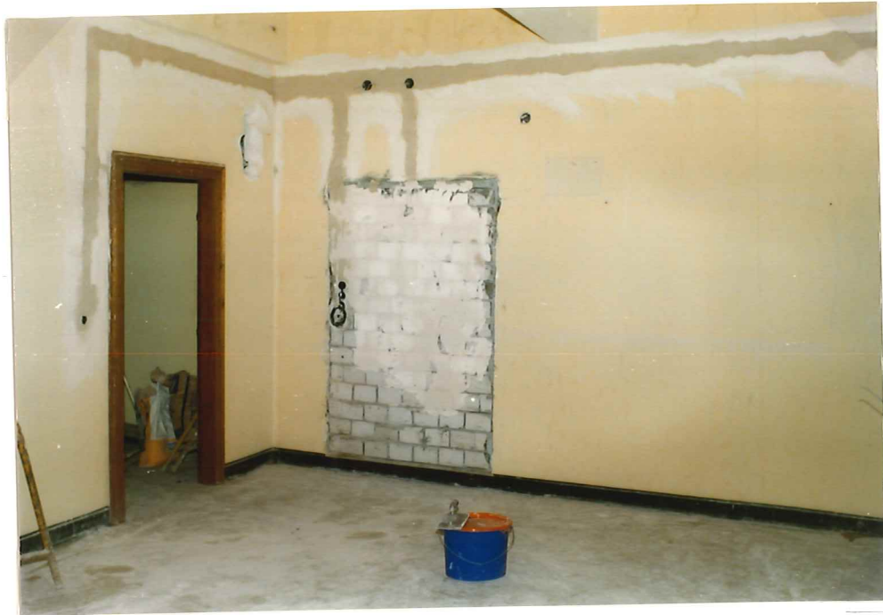
Die zugemauerte Schranknische im neuen Ämterzimmer
