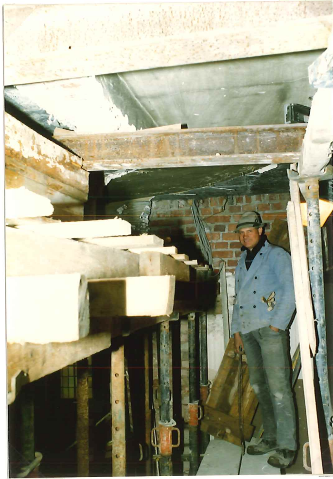
Der Unterzug zur Unterfangung
