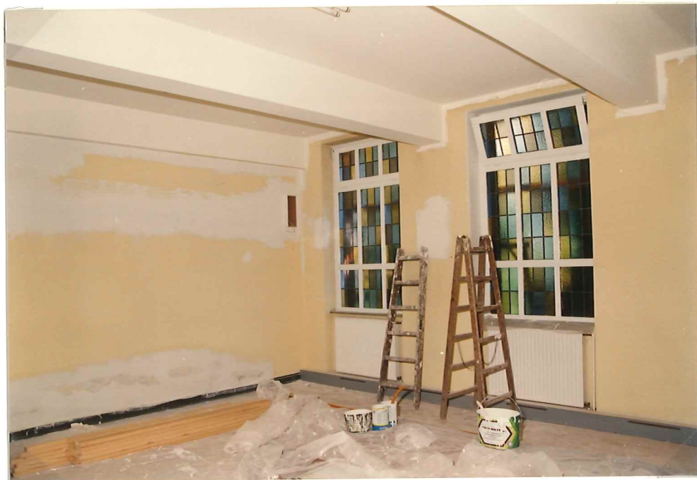
Schließung aller Schlitze und Durchbrüche, hier im Jugendraum
