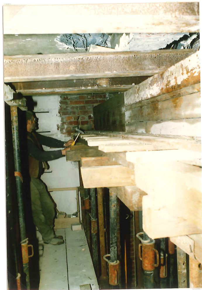
Der Unterzug zur Unterfangung
