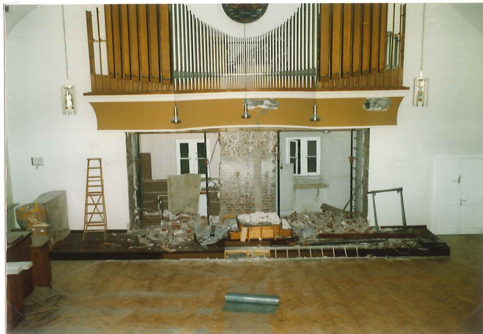
Der neue Altarbereich nach Abbruch des Überset- zerraumes und des alten Balgraumes
