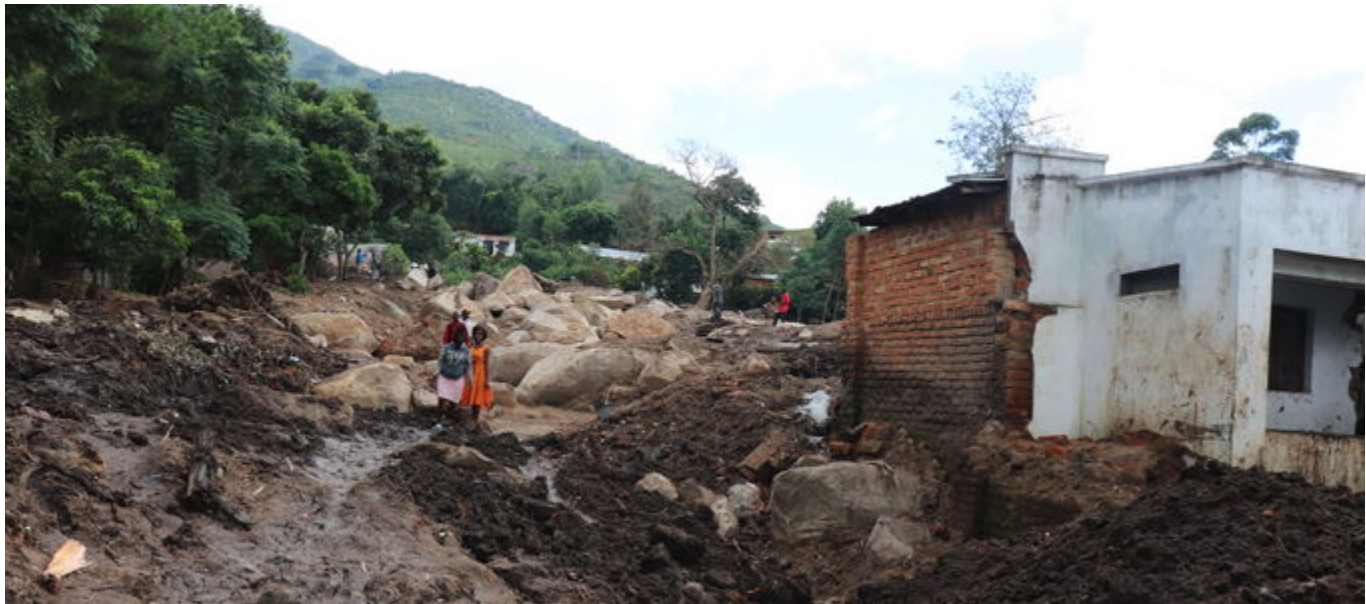
Sturmschäden in Chilobwe
